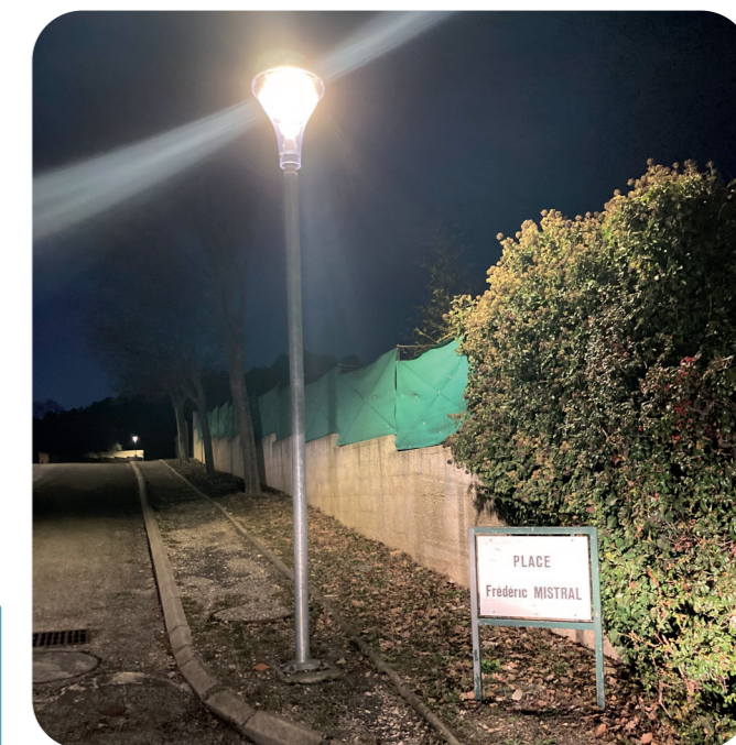
Candélabres à leds à modulation de puissance - Tranche 1, Place des tilleuls.
