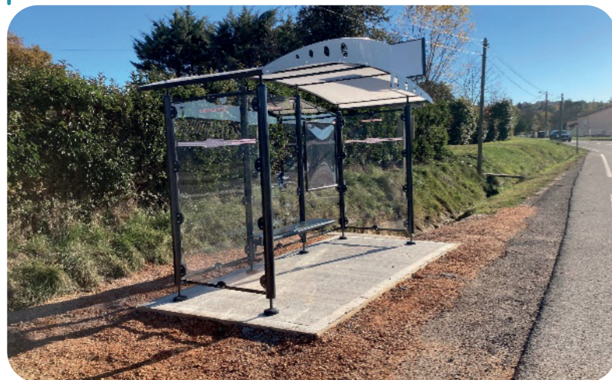
Abribus du groupe scolaire.
